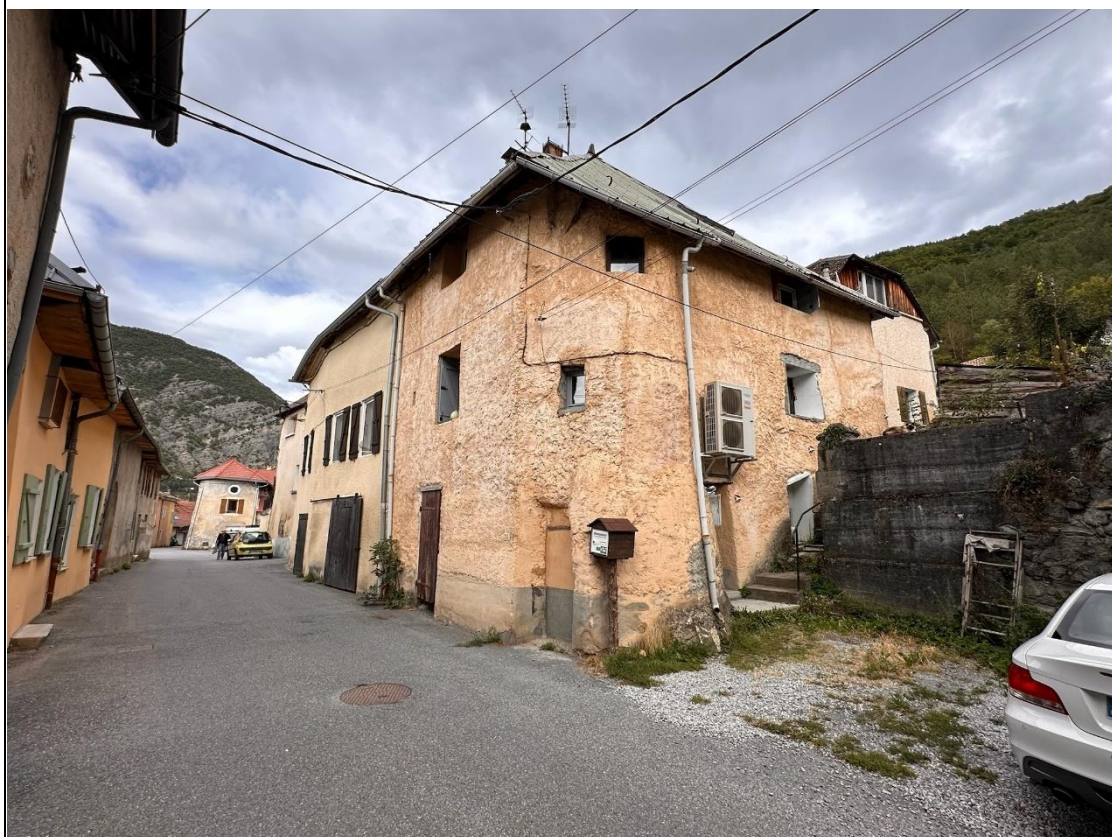
Façade Nord/Ouest longeant la Route D942A dénommée « Gran 'Rue » :
