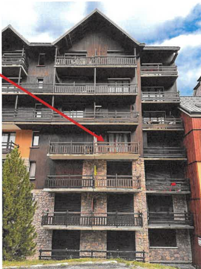
Entrée du bâtiment A la Résidence « Le Christiana » :
