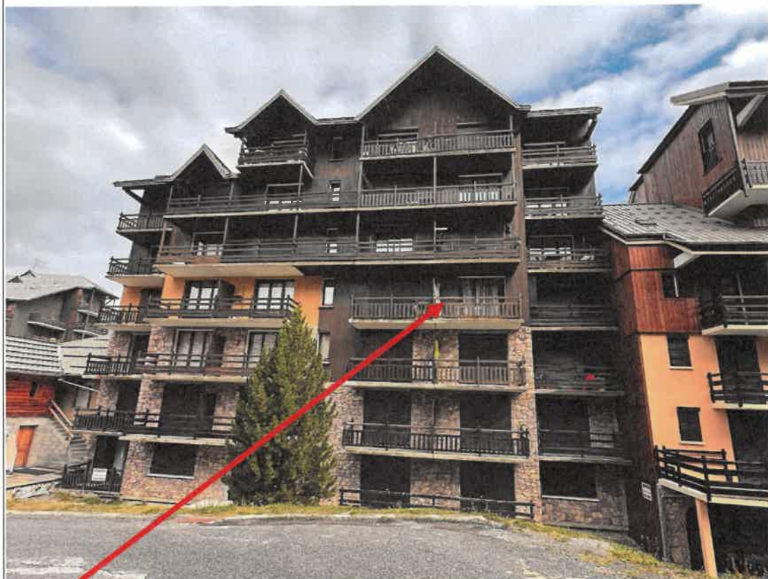
Façade Sud du bâtiment A de la Résidence « Le Christiana » :
